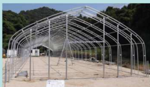
耐雪型2重アーチハウスの導入
